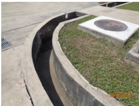
ภาพที่ (9) ระบบระบายน้ำฝน
